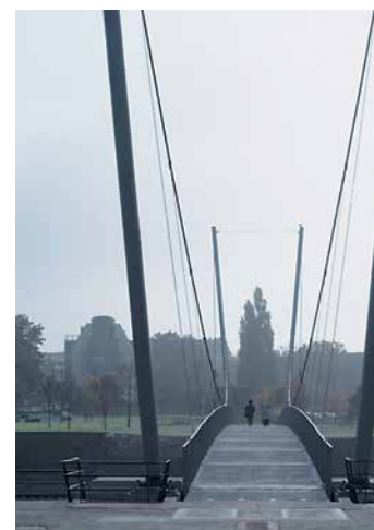
Wanneer de masten naar buiten wegdraaien, komt de brug in het midden 10,6 m omhoog. In de normale stand is het peil van het brugdek 1,1 m.
