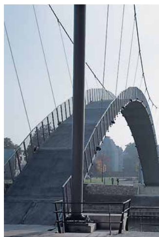
Wanneer de masten naar buiten wegdraaien, komt de brug in het midden 10,6 m omhoog. In de normale stand is het peil van het brugdek 1,1 m.
