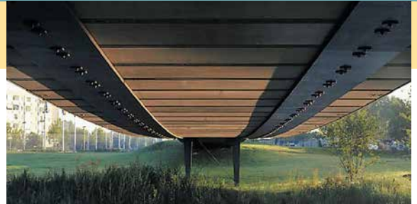
De platen van prefab beton zijn met bouten aan de spanbanden bevestigd.
