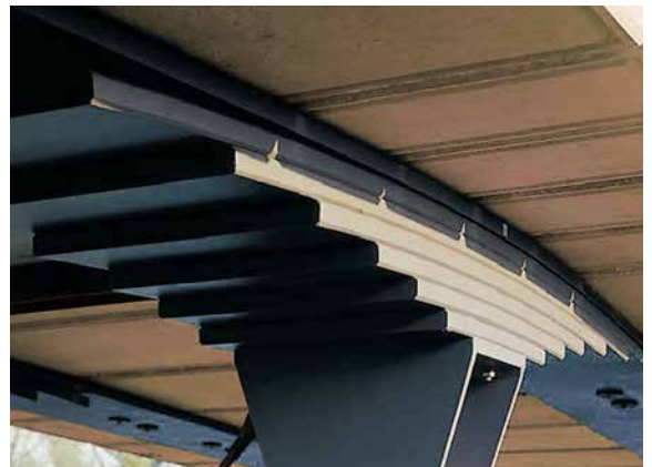
Bladveren vormen lichtgebogen zadels waarover de spanbanden als snaren zijn gespannen.
