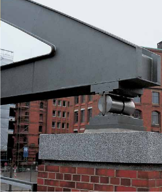
Rolopleggingen leiden de verticale belasting uit de vakwerkbruggen naar de fundering.
