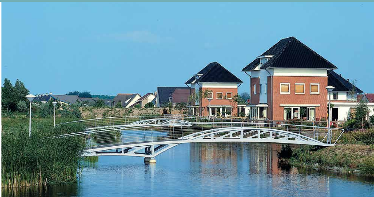
Twee bruggen met een asymmetrische constructie verbinden de woonwijk met het park.
