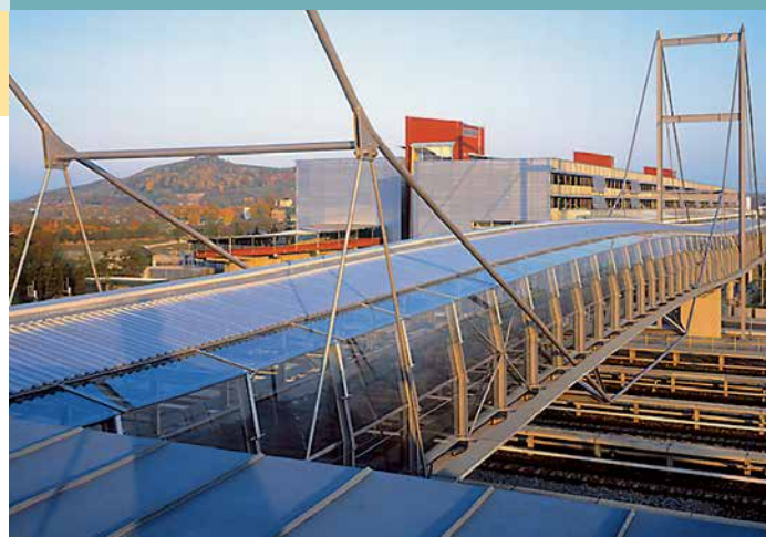
De stalen hangbrug overspant in één keer 79 m; de breedte van het spooreplacement.
