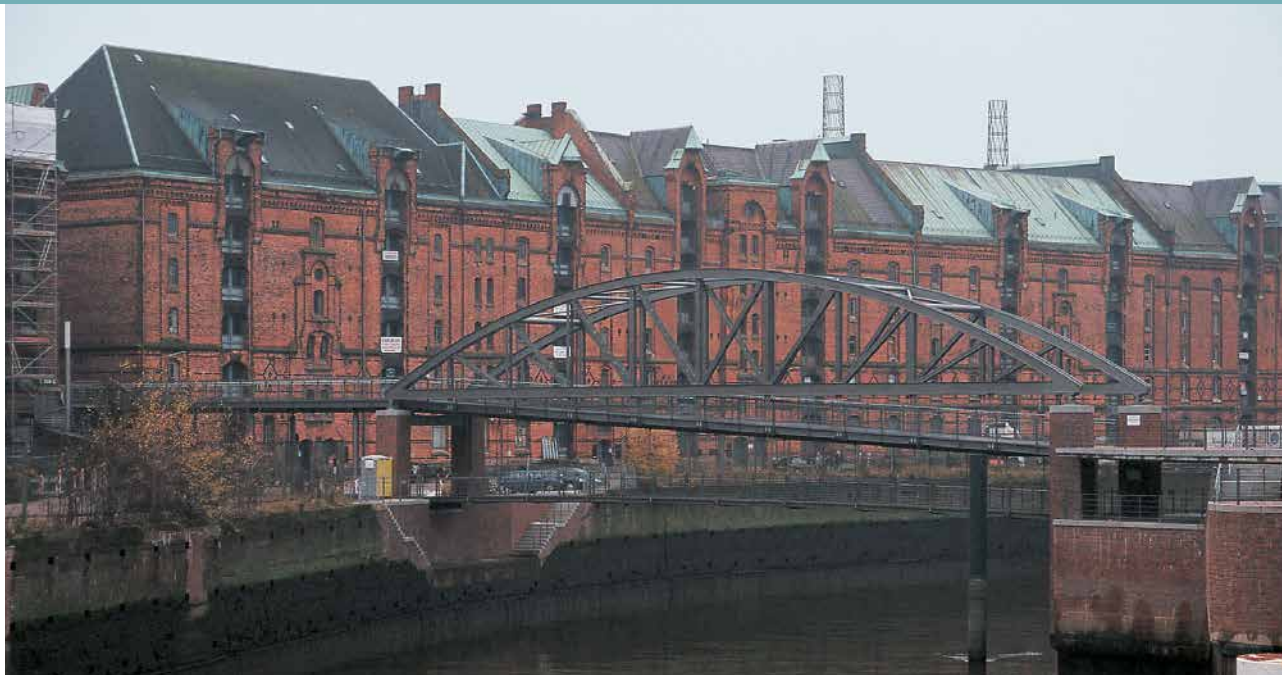
De vakwerkbrug over het Tollkanal in Hamburg heeft twee dekken en maakt deel uit van een driedelig brugcomplex in het havengebied met pakhuizen.
