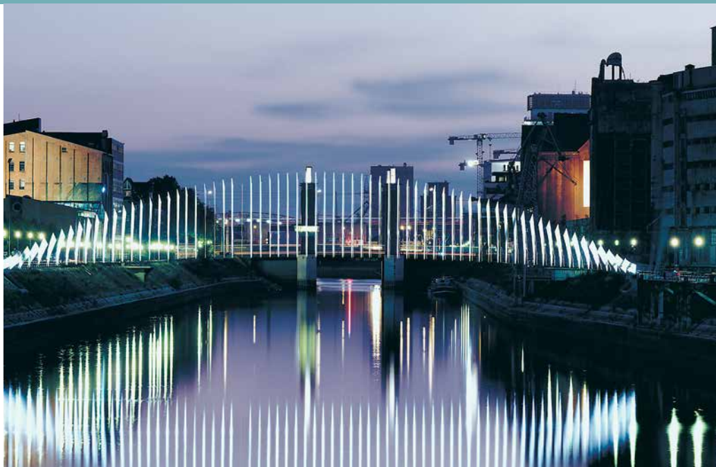
's Nachts is de brug aangelicht door een geïntegreerde LED-lijnverlichting.
