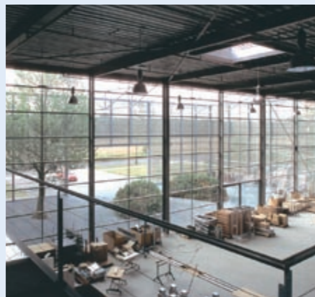
1.3 Slanke constructies nemen weinig ruimte in en zorgen voor een transparant gebouw met veel daglicht.
