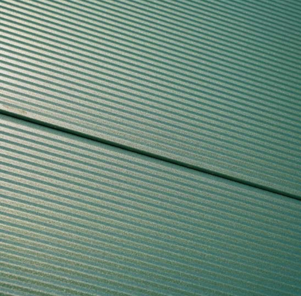
Sandwichgevel met parelmoercoating Foto: SAB-profiel
