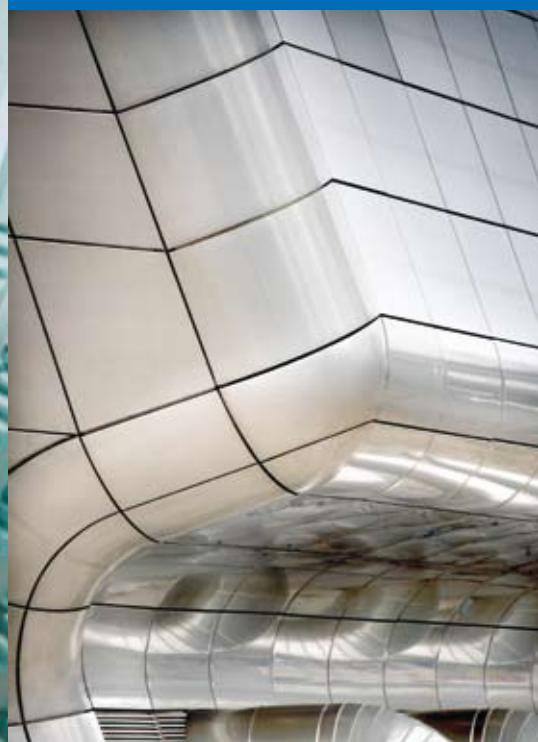
Boostergemaal: roestvast staal in exploform Amsterdam 2006, GroupA
