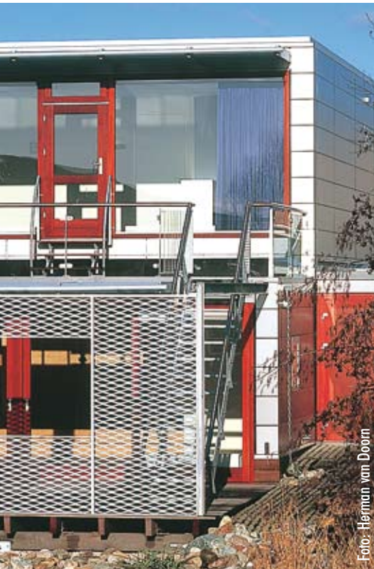
Steel Study House: strekmetaal en sandwichpanelen Zoetermeer 2003, Archipel Ontwerpers
