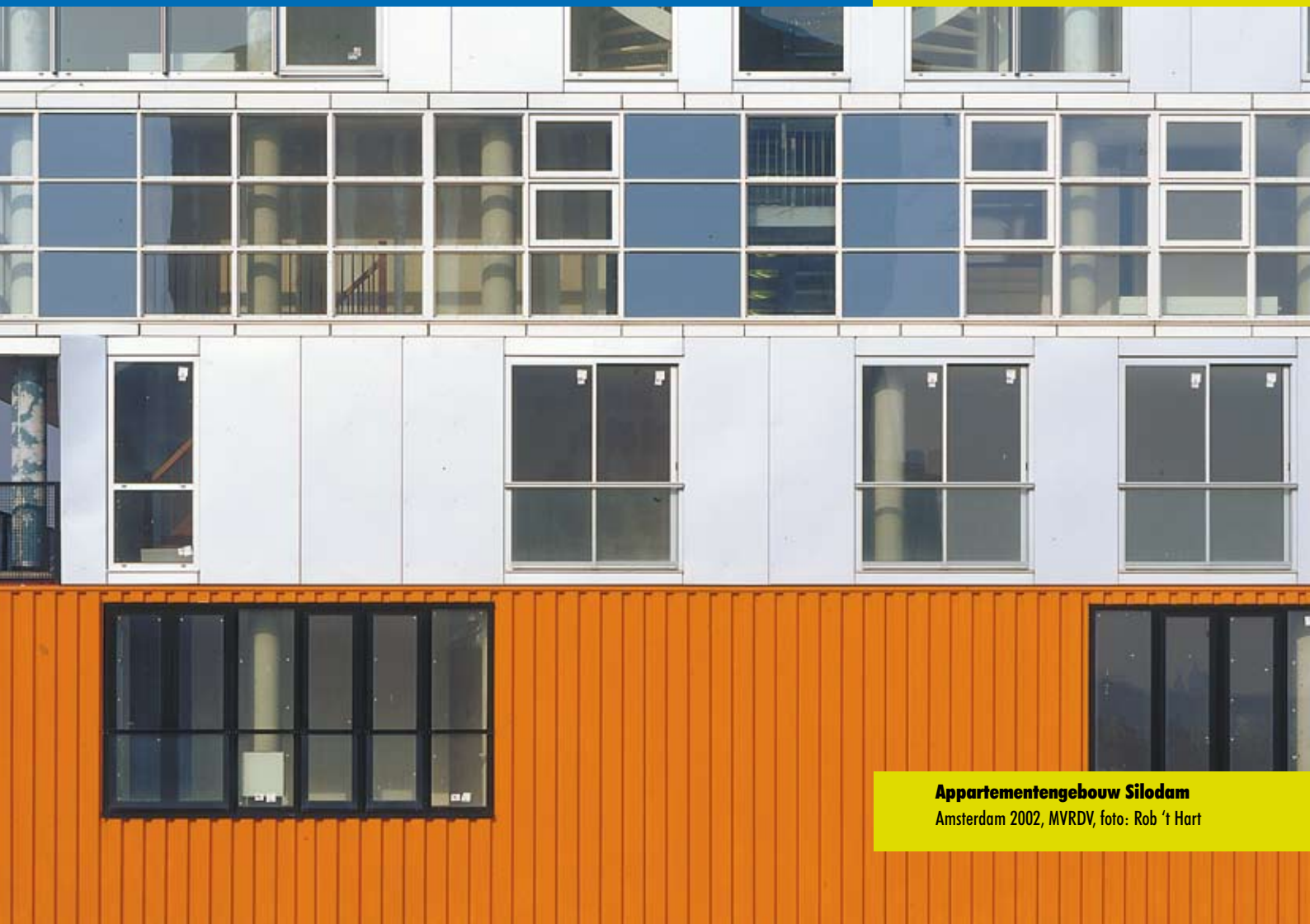
Sandwichgevel met parelmoercoating Foto: SAB-profiel
