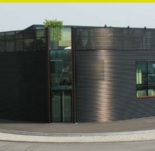
De gevel bestaat deels uit geperforeerde platen
