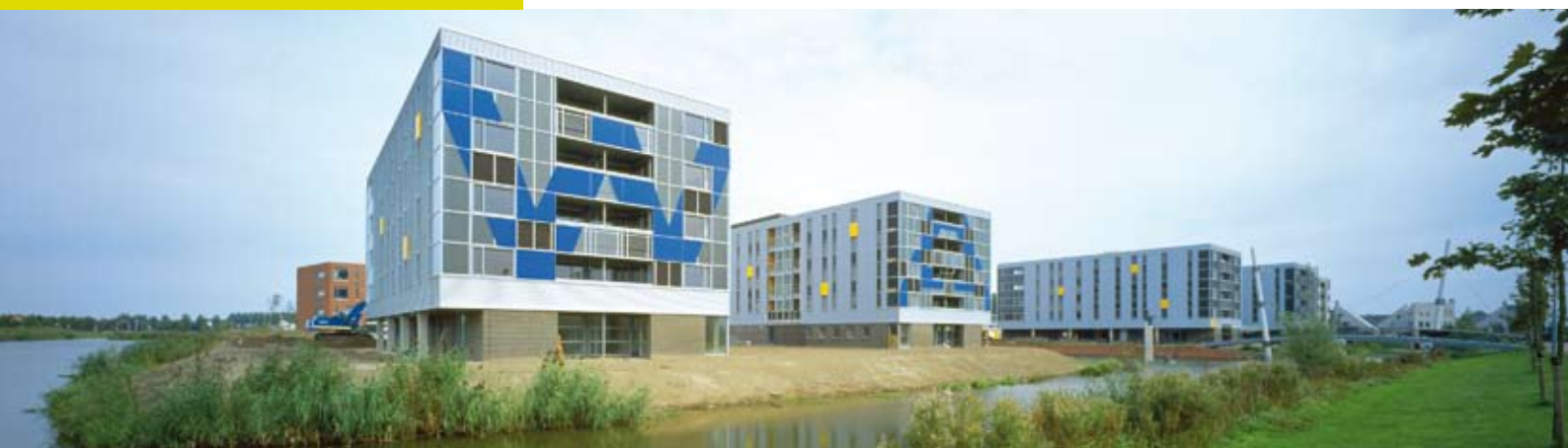
De plint en dakrand in de kopgevel zijn bekleed met geprofileerd staalplaat
