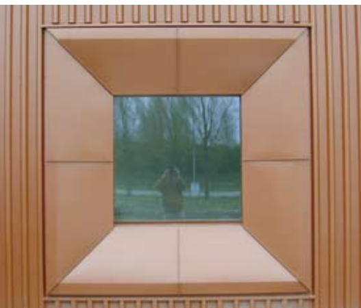
Raam in kopgevel met kader in staal
