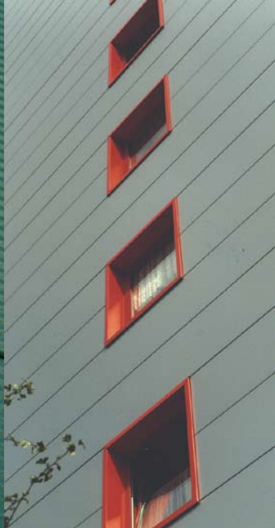
Sterflats: renovatie met sandwichpanelen Delft, DE Architecten
