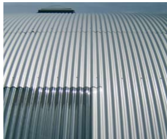
Dak en gevel met 'golfplaat'
