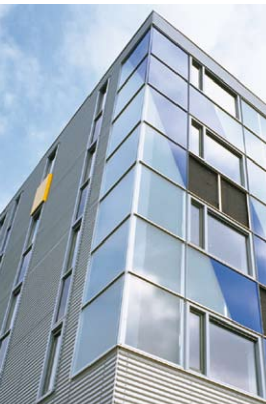
De plint en dakrand in de kopgevel zijn bekleed met geprofileerd staalplaat
