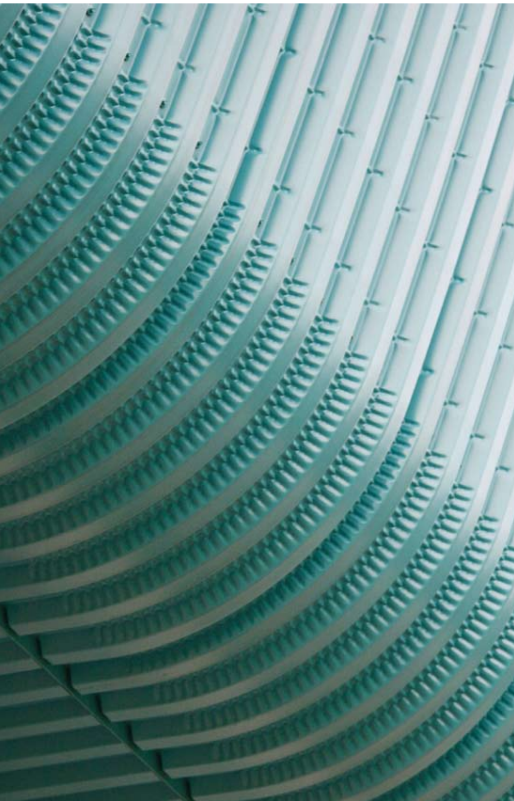
Gebogen geprofileerde plaat door knikken Foto: SAB-Profiel
