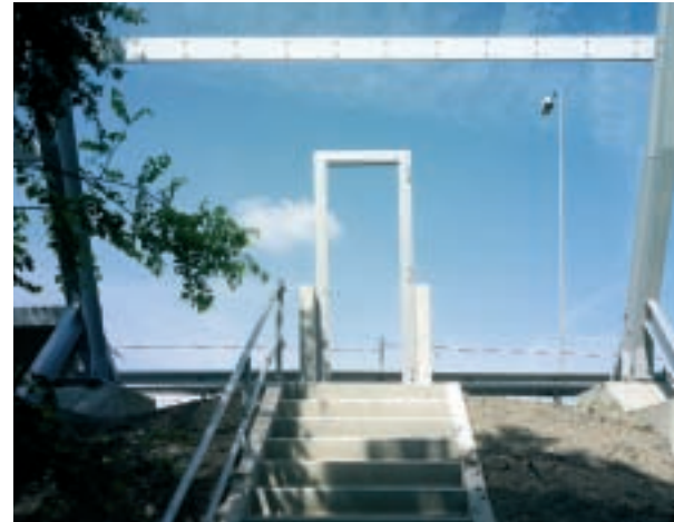
De ongunstige ligging aan de snelweg boodt een ingang voor subsidie. Dat de optop in staalframebouw ging kwam door de onderscheidende kwaliteiten van dit bouwsysteem en de concurrerende prijsstelling.
