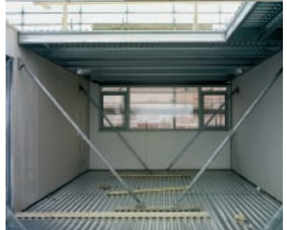
De vloer- en wandelementen worden in de fabriek geproduceerd en op vrachtwagens naar de bouwplaats vervoerd. De elementen worden als pakket op het dak gehesen. Bouwbaken steunen de wandelementen.
