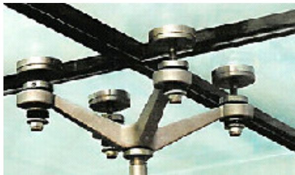
Glazen gevel/dak constructie
