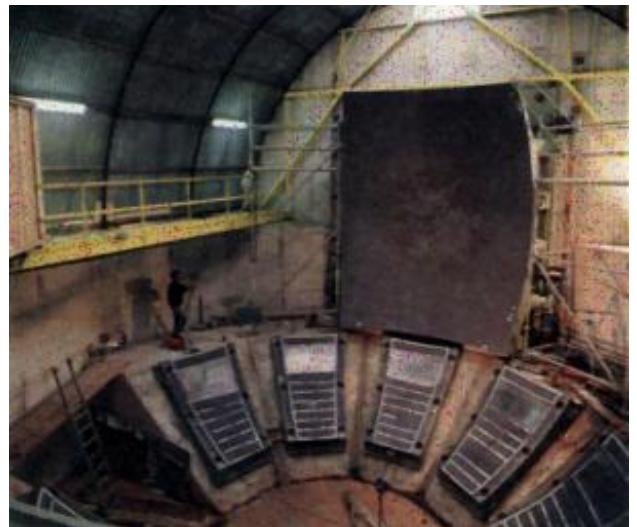
Figuur 50 bolscharnier Maeslantkering
