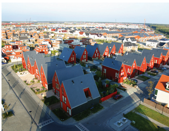
Achttien 'Multiple Choice'-woningen, Almere. De staalframebouw vloeren en dakgordingdozen zijn gemonteerd in een hoofddraagconstructie van warmgewalste profielen.
