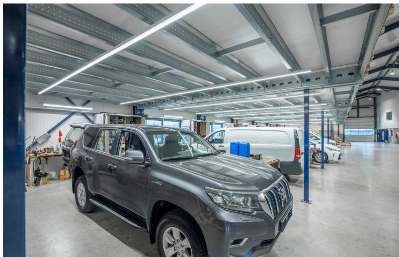
7.10 ASH Carrosserie, Middelharnis. Grote vrije overspanningen dankzij hoge, koudgevormde entresolvloerprofielen (foto: Anera).
