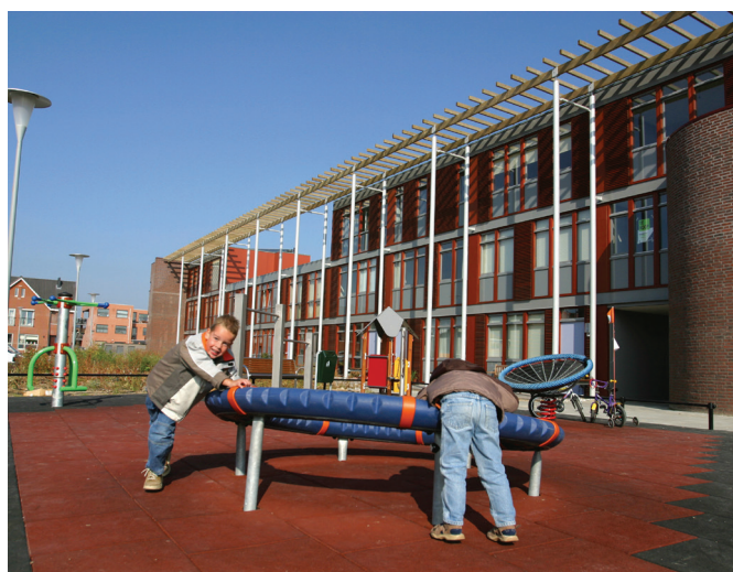
Wenswonen te Zaltbommel. De huidige en toekomstige bewoners hebben de optie op een extra verdieping en/of een grotere leefruimte op de begane grond. De staalframebouw optop- en aanhangmodules worden gemonteerd aan een betonnen casco.
