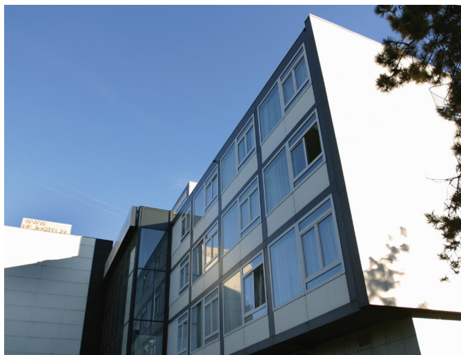
Best Western-hotel, Amsterdam. Als een zelfdragende 'carrosserie' zijn vier bouwlagen van staalframebouw opgetrokken. Nadien is daaraan nog een laag toegevoegd en de rest van het hotel ook opgetopt.
