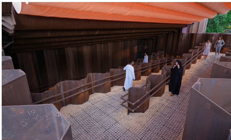
7.16 Nederlands paviljoen voor de wereldtentoonstelling in Dubai in 2020. Het gebouw is na de tentoonstelling gedemonteerd en alle materialen, inclusief de fundering, zijn als losse componenten hergebruikt (foto: Jeroen Musch).
