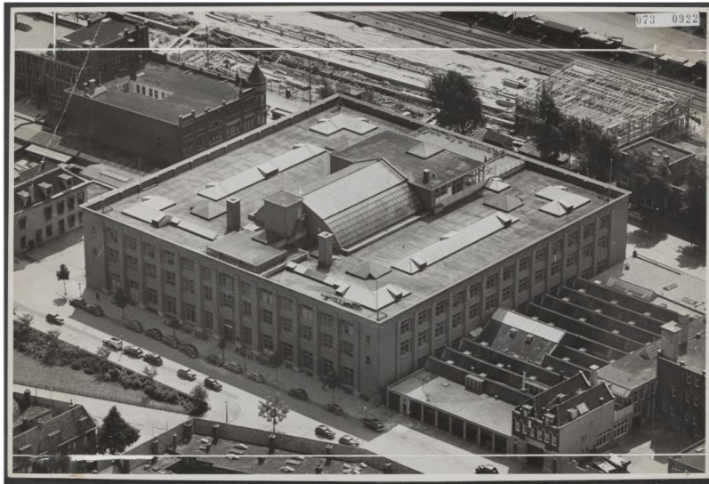
75a Oude gebouw van Stokvis & Zonen in Rotterdam...
