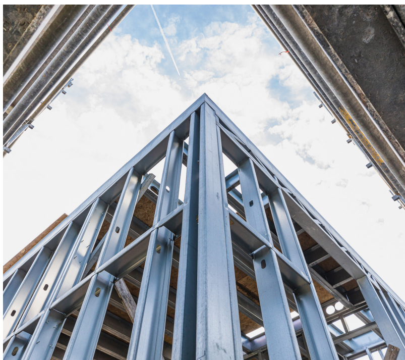
8.5 De zinklaag beschermt de constructie tijdens de ruwbouwfase (foto: BeSteel).
