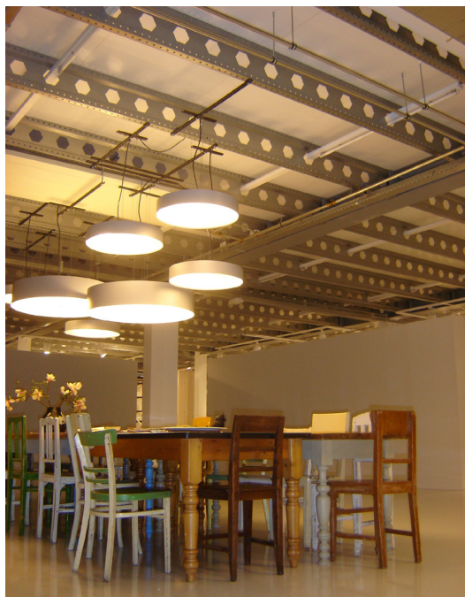
7.8 De nieuwe vestiging van kinderkledingzaak Tumble 'n Dry in Amsterdam heeft een industrieel uiterlijk, passend bij de nieuwe huisstijl, dankzij een tussenverdieping met de staalprofielen (rechtstreeks tegen en op de bestaande constructie) nog in het zicht.
