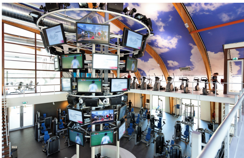
7.9b Sportcomplex Victorie Plaza. Tegen de bestaande gelamineerde houten spanten en op een nieuwe staalconstructie zijn staalframebouw vloeren met een toplaag van 4 cm spaanplaat aangebracht.
