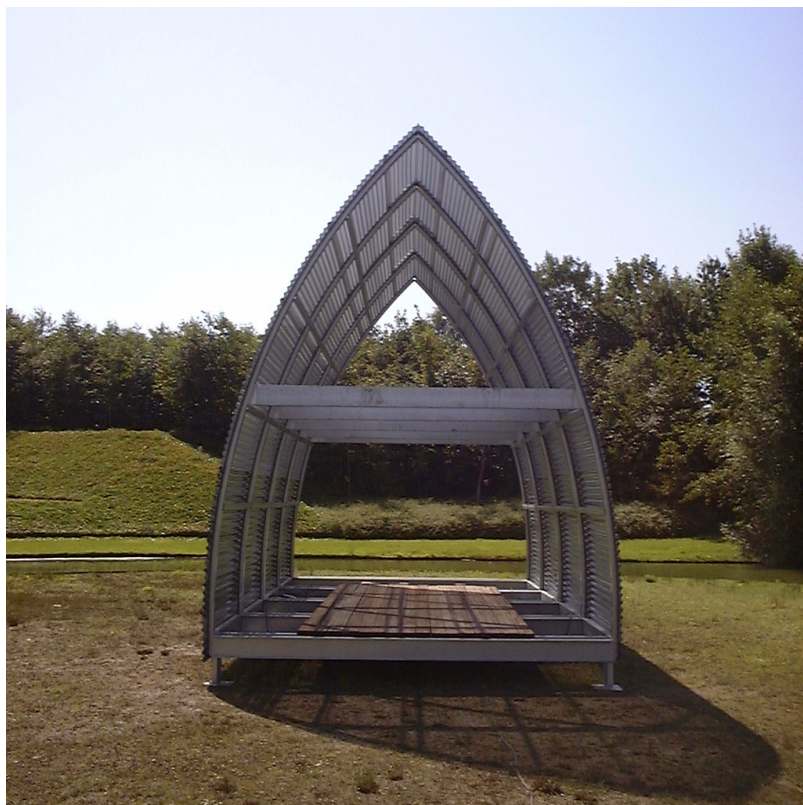
8.4 Woonconcept uit België. De corrosiesnelheid van de zinklaag in corrosieklasse C2 (platteland) is \pm 0,1-0,7 \mu\text{m/jaar} .
