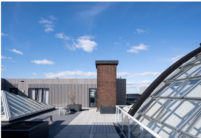
75c ... met optoplofts en riant dakterras (foto: Ossip van Duivenbode).
