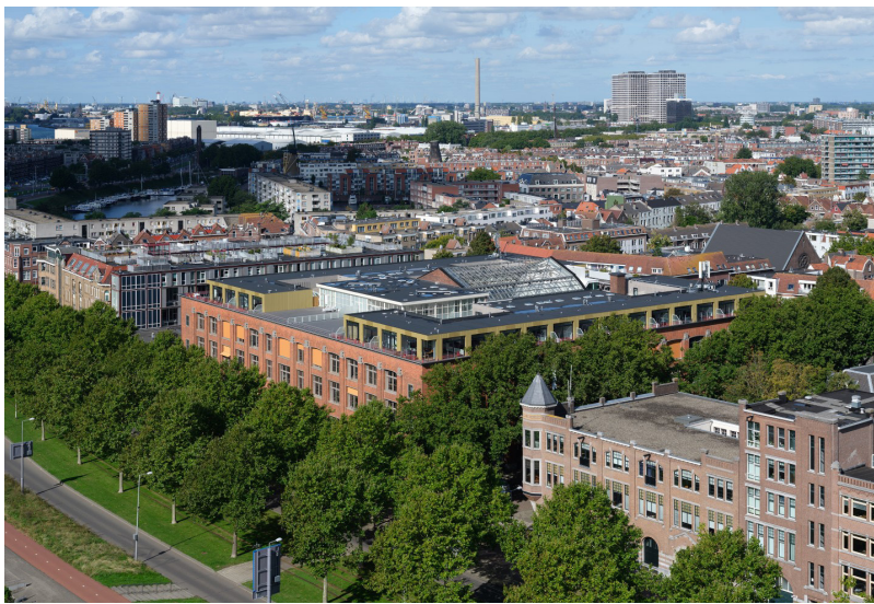
75b ... is nu appartementencomplex West507... (foto: Ossip van Duivenbode)
