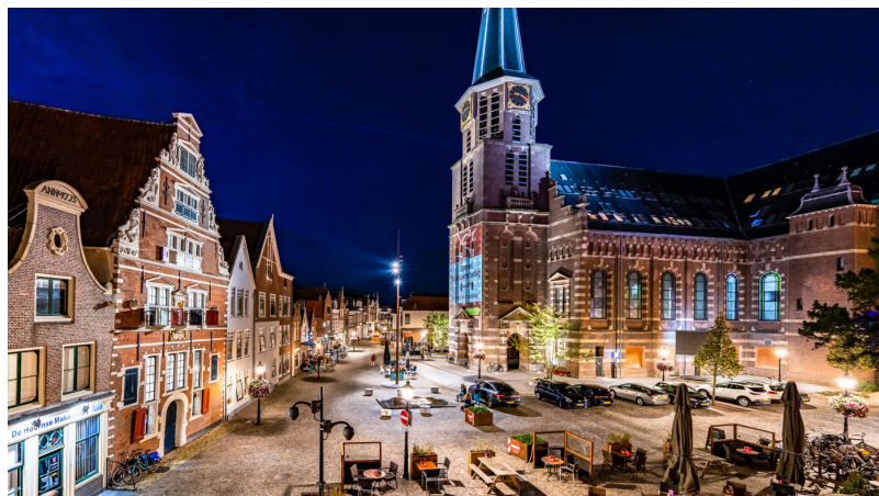
7.4 Transformatie van kerk naar hotel in Hoorn.
