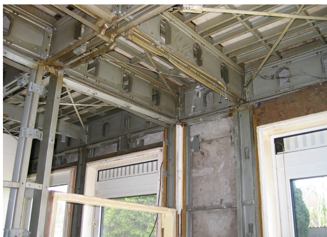
7.14 a en b Demontage Polynormprofielen voor hergebruik bij proeflab op het TU/e-terrein.
