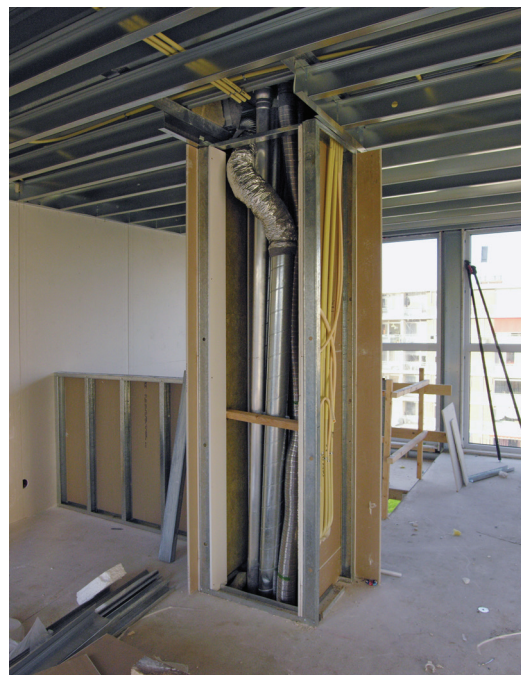
5.16. Voorkom koppelingen tussen (stand)leidingen en schachtwanden. Bij voorkeur (stand)leidingen van vloer naar vloer monteren.
