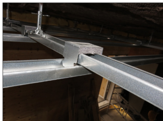
5.8. Door de plafondplaten flexibel op kruislings gemonteerd regelwerk te monteren, gaan de geluidprestaties sterk omhoog. Type vilt en aantal steunpunten zijn afhankelijk van de massa van de beplating (foto: Wim Beentjes).
