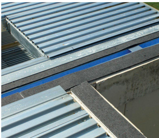
5.13. Lip waarmee de vloer op de wand steunt, op ontkoppelingsmateriaal leggen. Naast het effect op de verbindingdemping, wordt het kraken van staal op staal voorkomen.
