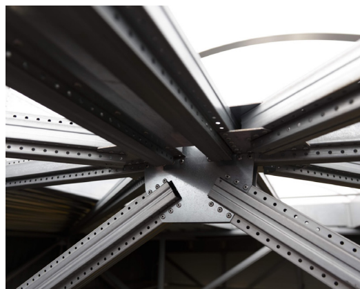
2.17.b. Speciaal 'kruisprofiel' met klinknagels.
