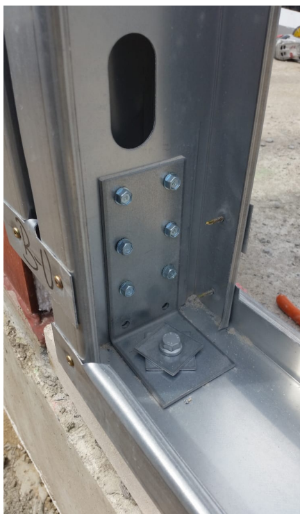
3.15. Verankeringsstypen bij open frames (foto's: BAAS architecten en CFP, rechts).
