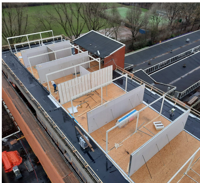
3.17a en b. Optop schoolgebouw met volledig prefab elementen (foto's: MFrame).
