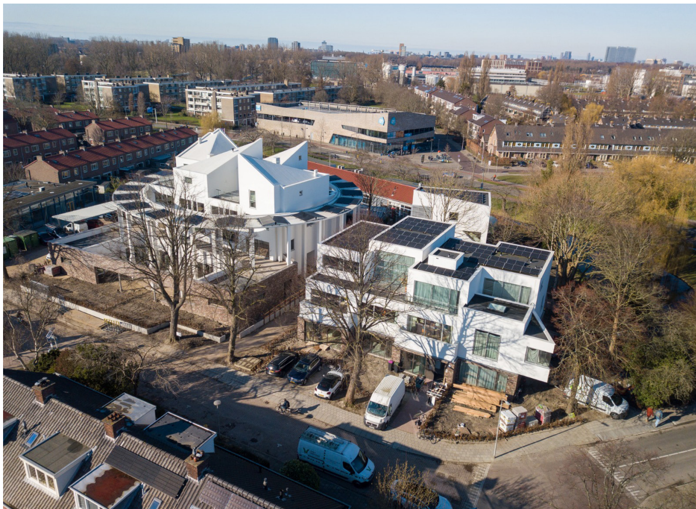
1.9. Het terrein van de Pastoor van Arskerk in Delft is getransformeerd (2023) tot woongebied met zestien koopwoningen, waarvan tien 'cirkelwoningen' op de oude fundering en tussen de gehandhaafde kooromgang (foto: C3 Staalframebouw).
