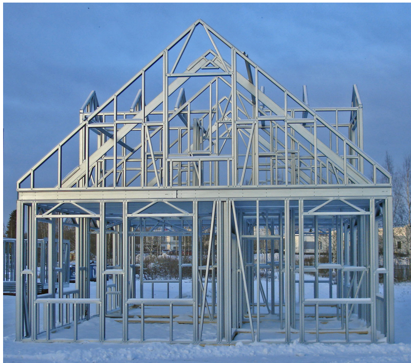
3.1. Productie op de bouwplaats (foto: Finish Profiles).
