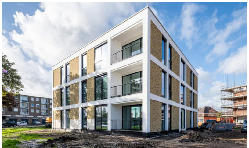
2.9. Gestapelde woningbouw met staalframebouw (foto: MFrame).
