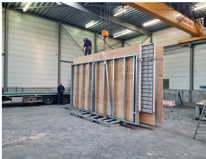
3.13a en b. Halffabricaten, vloer en wand, met gaten en sporingen (foto's: Finish Profiles).
