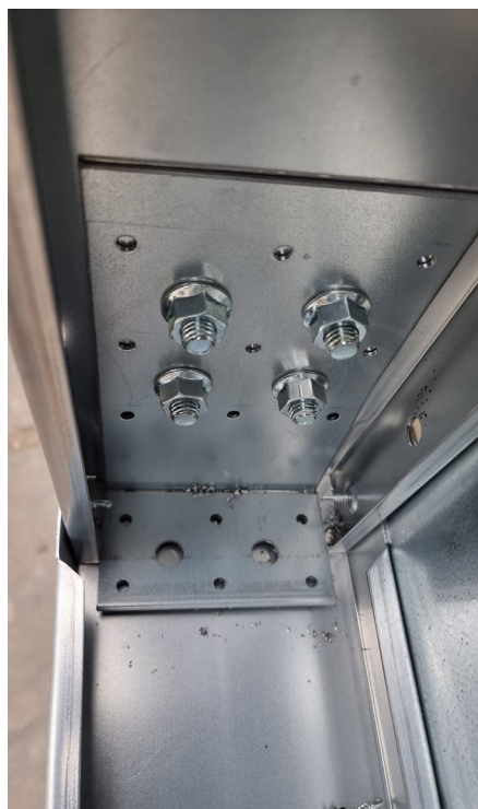
3.15. Verankeringsstypen bij open frames (foto's: BAAS architecten en CFP, rechts).
