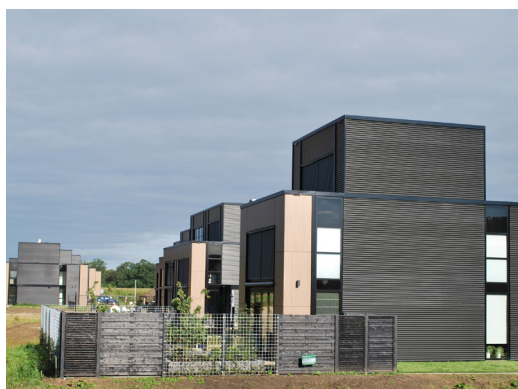
3.2. Prefab elementen voor assemblage-bouw (foto: Courage).
