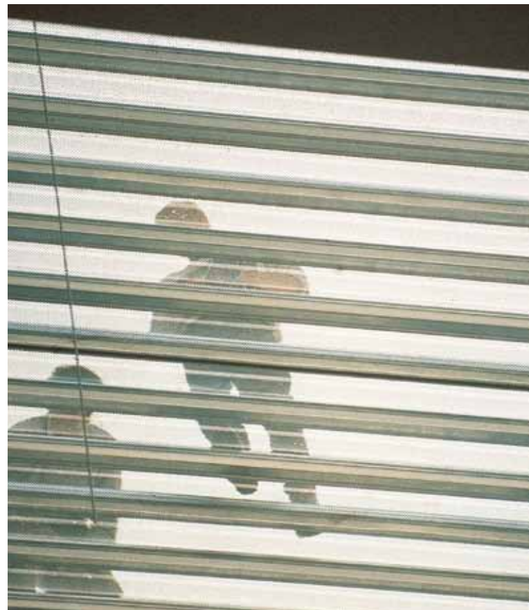
5.8 Met geperforeerde staalplaat zijn hoge geluidsisolatiewaarden mogelijk.
