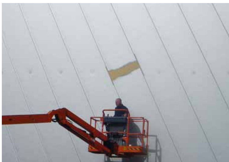
8.12 Beschadigingen en zelfs gaten zijn goed te behandelen en plaatselijk over te spuiten zonder noemenswaardig kleurverschil.
