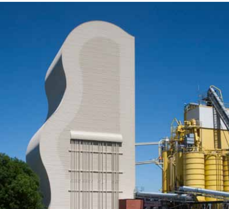
4.6 Het bedrijfsgebouw van Maxit in Eindhoven heeft een gevel van getoogde staalplaat. Met speciale walsen krijgen (standaard)platen een ronding (foto: Vincent Basler).
