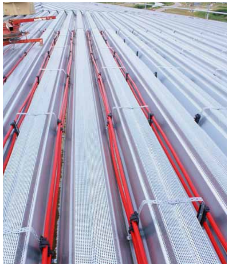
9.9 Overzicht van het dak van het Wilo-gebouw in Zaandam met paraffinekorrels ingestort in een betonlaag.
