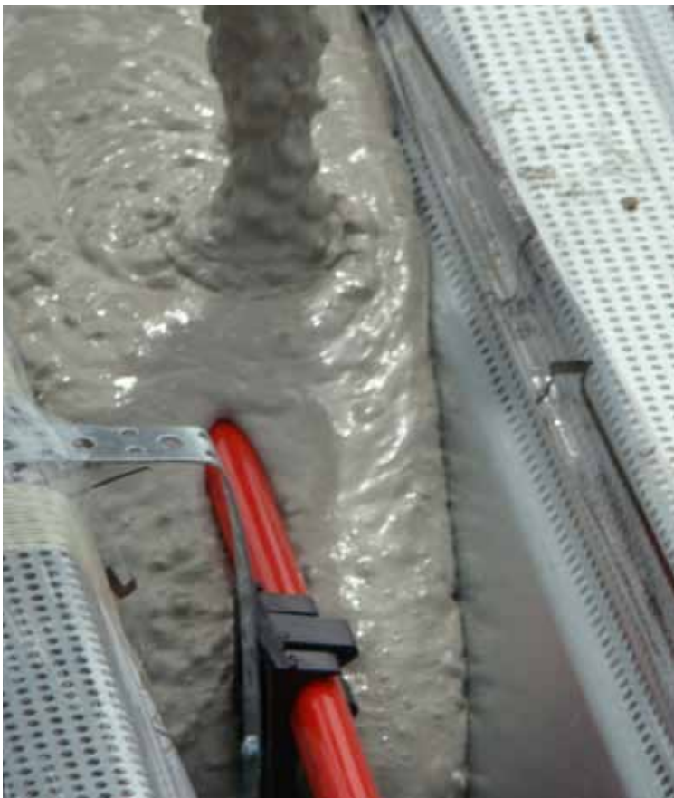
5.7 Paraffine als bufferend toeslagmateriaal tegen te grote temperatuurswisselingen.
