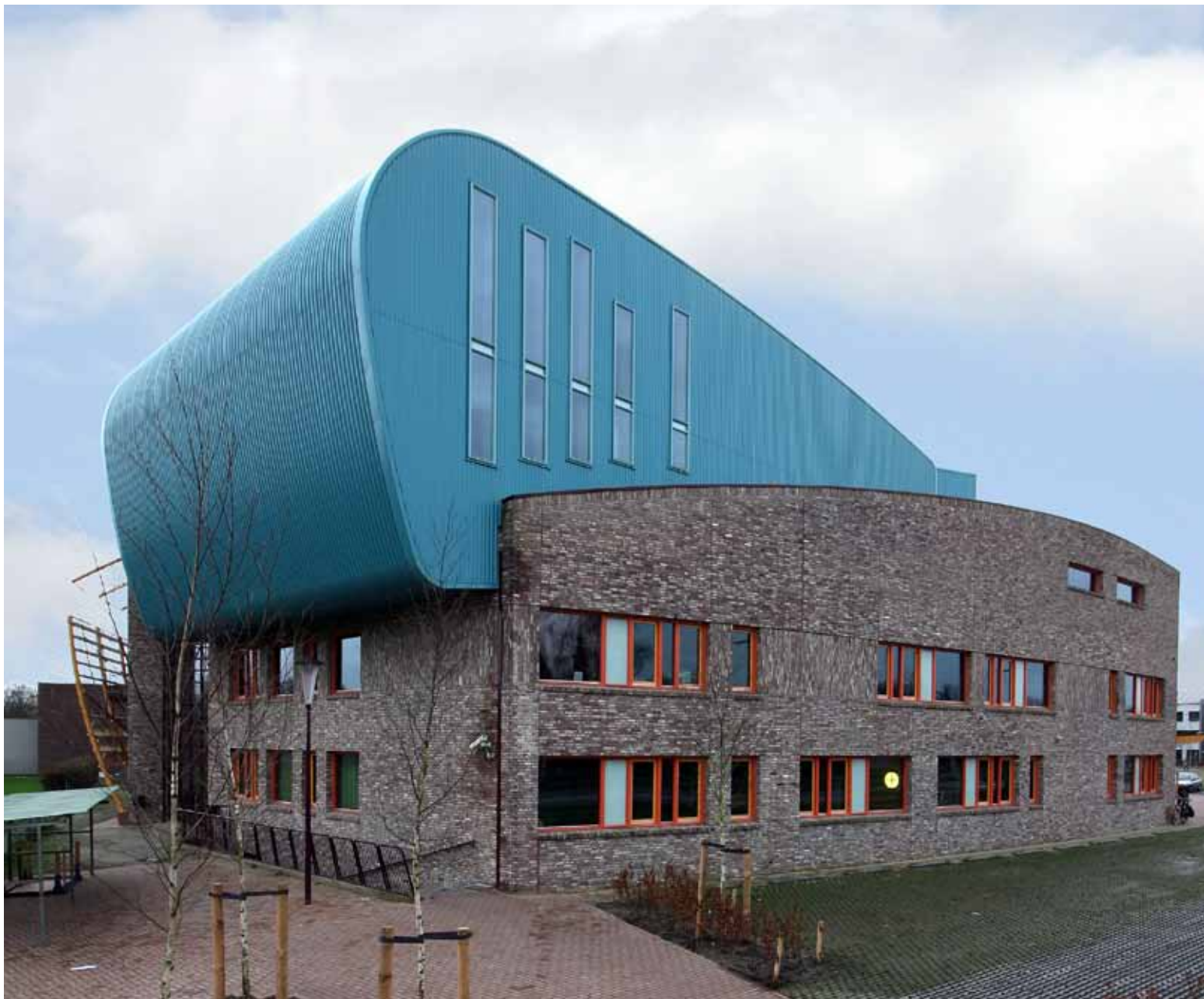
1.8 Met buigknikken kan vrijwel elke (eind)rondding worden gemaakt. Hier een voorbeeld aan het Novalis College in Eindhoven (foto:Rob Hoekstra).
