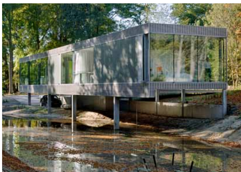
4.8 Perforaties geven 'diepgang' aan gevels zoals bij deze villa in Oranjestad (foto: Pieter Kers).
