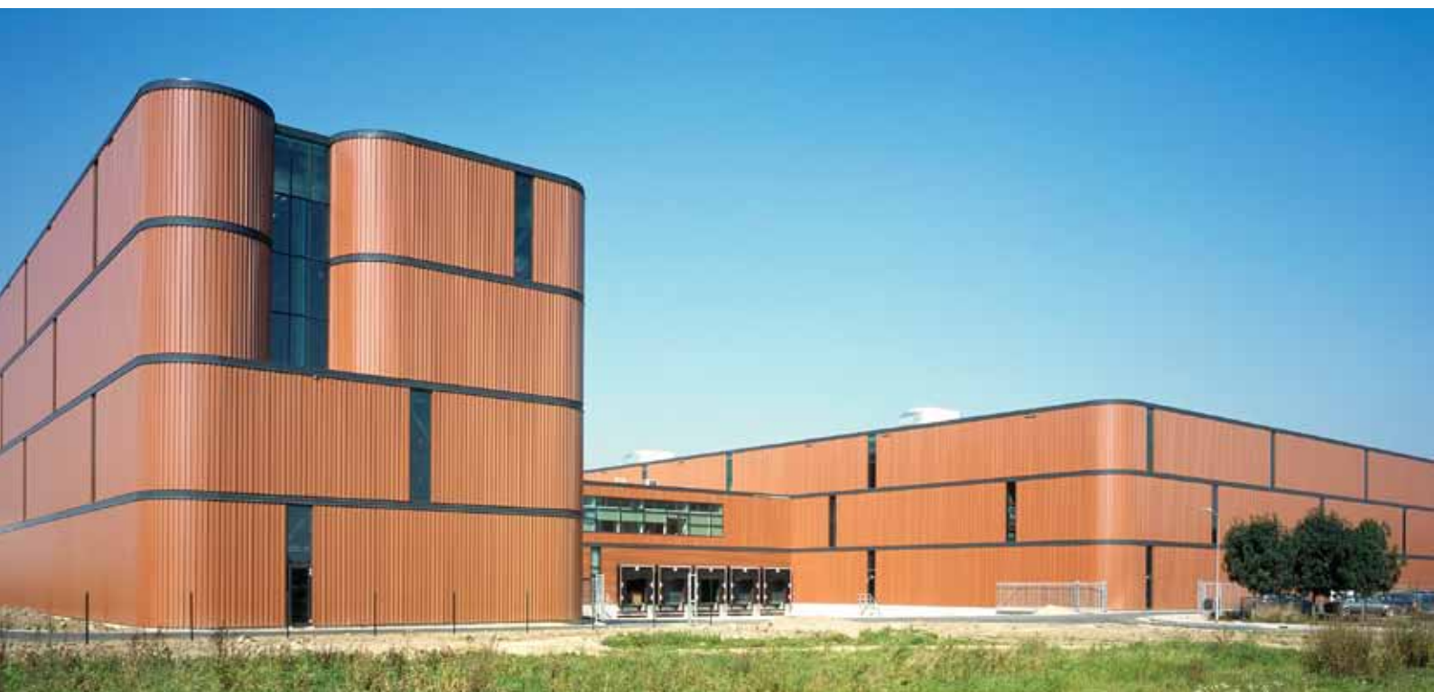
1.4 Ongeveer 90% van alle Nederlandse hallen heeft een voorgelakte stalen huid (foto: Martin Thomas).
