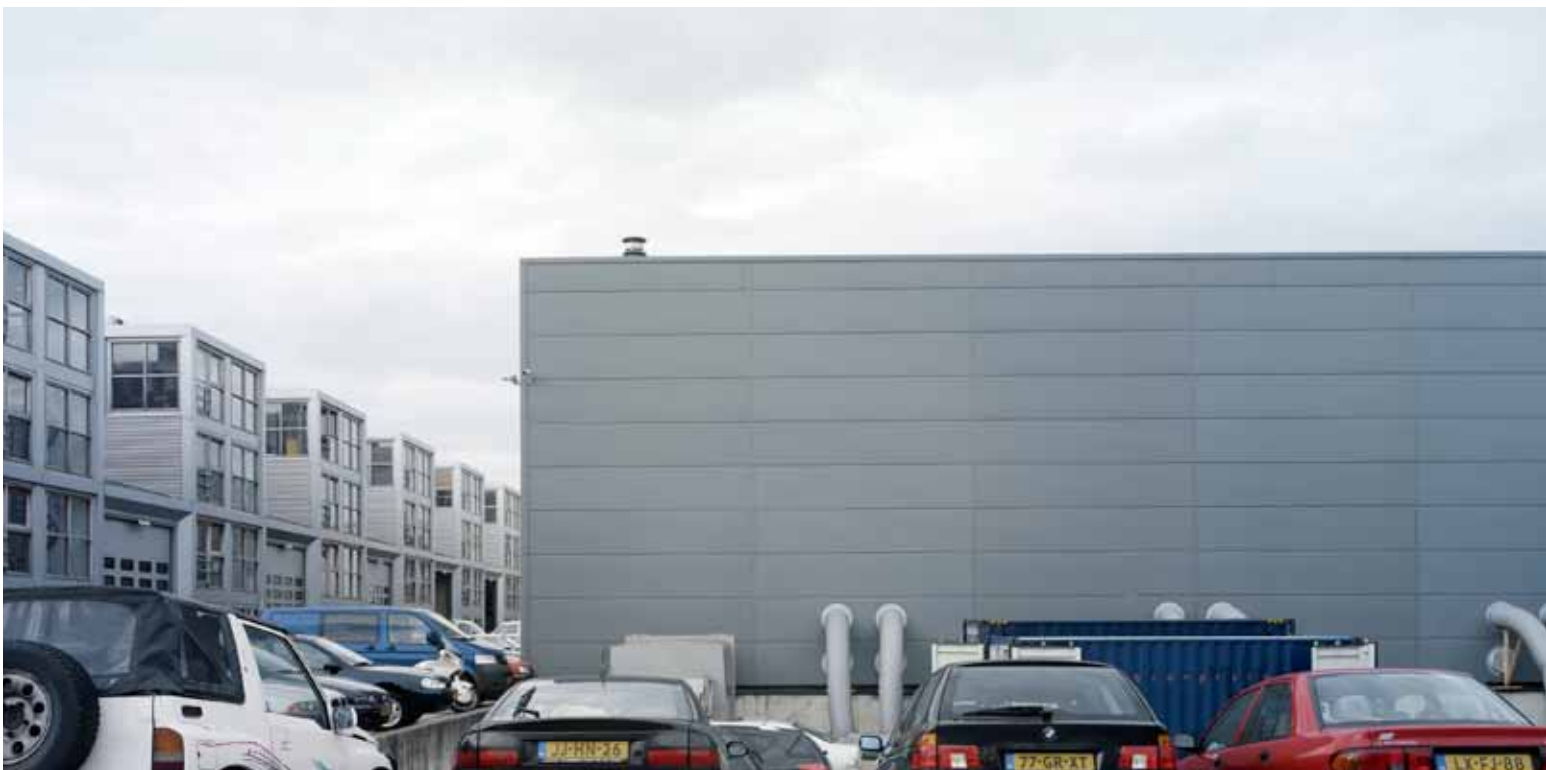
1.5 Het gebouw van Studio Nieuw Noord in Amsterdam is tot op het casco gestript en kreeg een nieuw tweelaagse gevel van geïsoleerde binnendozen en sandwichpanelen (foto: Luuk Kramer).
