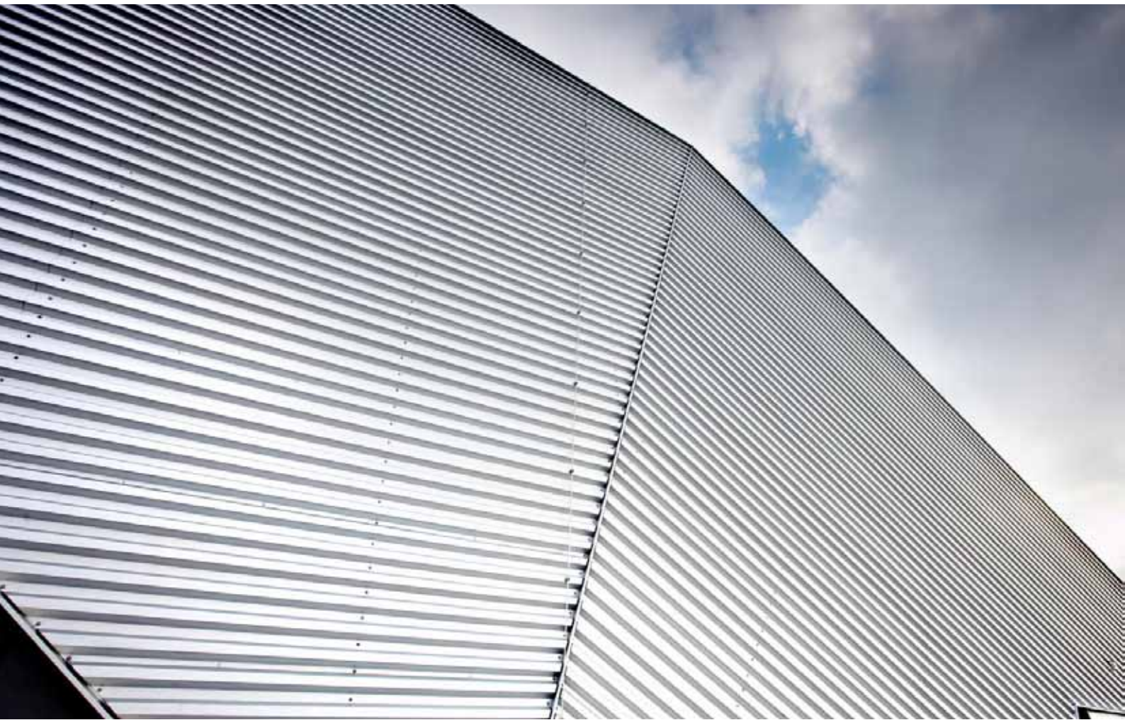
2.3 Een geprofileerde staalplaat met uitsluitend een aluminiumzinklaag is gebruikt voor de bekleding van douanegebouw X-Ray-Scan in Rotterdam (foto's: GroupA).
