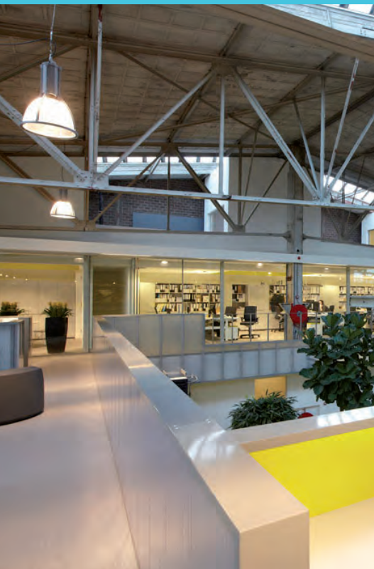
De bestaande draagconstructie van staal geeft ruimte voor een nieuwe indeling van de hal.
