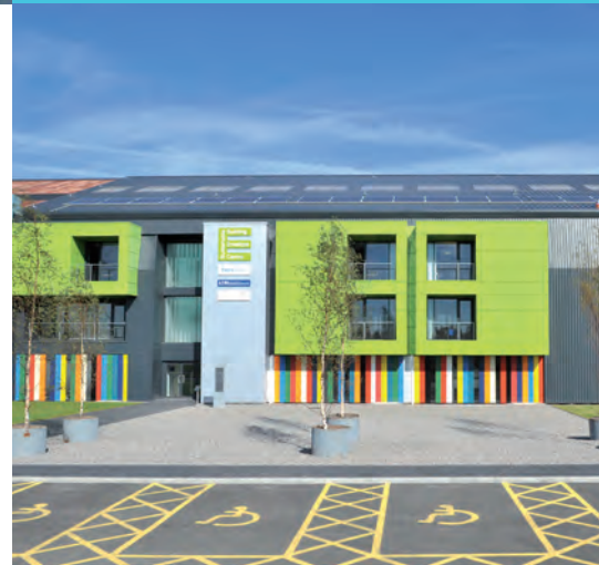
SAB-Zonnecollector volgens het Colorcoat Renew SC. Een gevelsysteem met perforaties voor de opvang van warme lucht.
