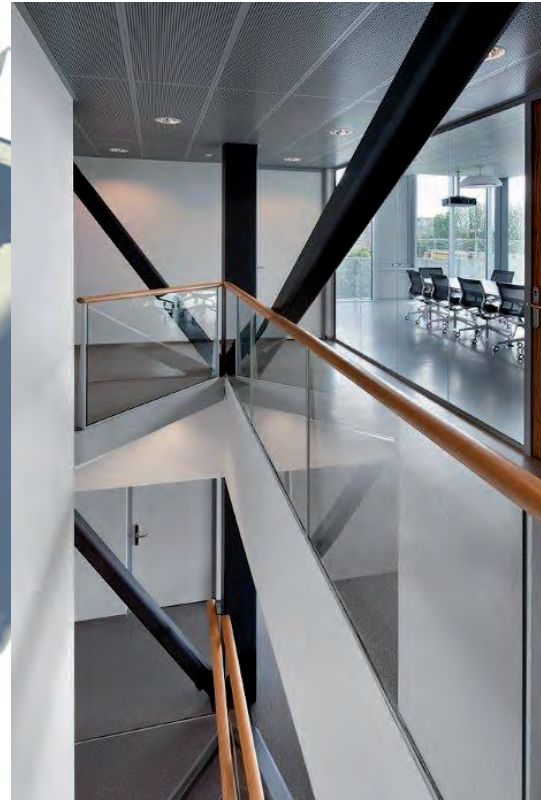
De opbouw ontleent zijn stabiliteit aan twee kernen (met trappenhuis en lift) met een stalen vakwerk (onder).
