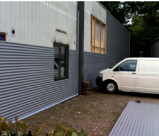
Voorzetgevel bedrijfspand Apeldoorn 2010.
