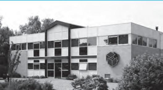
Oude situatie bedrijfsgebouw Vink Bouw, vóór de renovatie van Ben Kraan Architecten.
