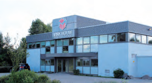
Gevel- en dakrenovatie (6 maanden) van Vink Bouw met pv-cellen en betere isolatie, Nieuwkoop 2012.
