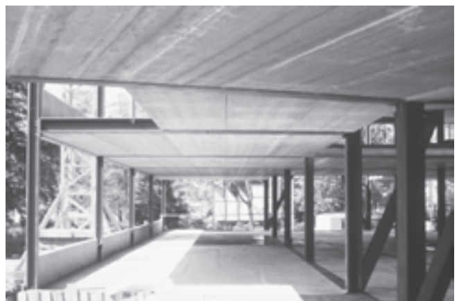
1.10. IFB-ligger (Arbed) in (a) hoogbouw Pleiad, Brussel (België, 1992) en (b) hoofdkantoor van Arbed, Esch-sur-Alzette (Luxemburg, 1992).
