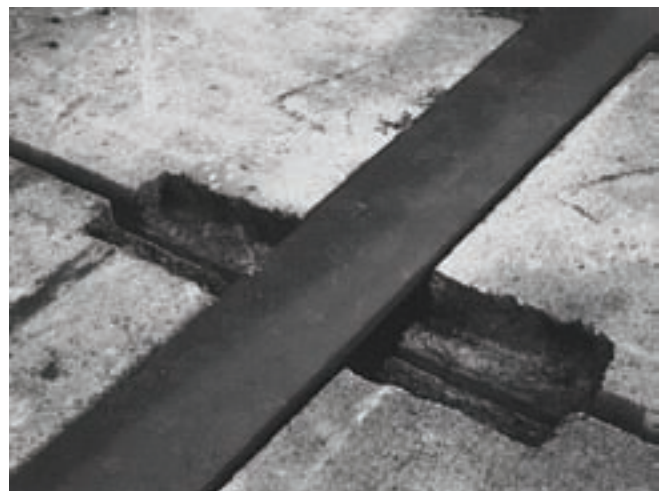
6.5. Schuifvaste verbinding tussen kanaalplaten en een vloerligger (type 2b) in drukkerij Wouda in Katwijk (1992).
