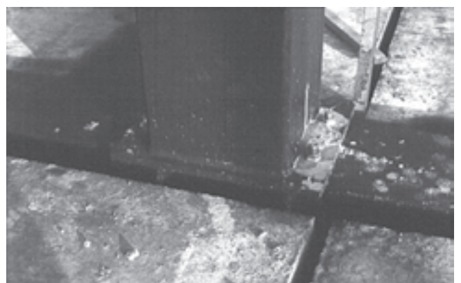
6.7. Verbinding tussen vloerligger en kolom (type 5b) in het kantoorge- bouw van Unidek in Gemert (1994).
