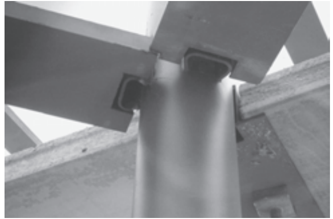
1.5. THQ-ligger (PPTH) in het kantoorgebouw Holec, Waddinxveen (1992): (a) overzicht; (b) aansluiting van de liggers aan een ronde kolom.
