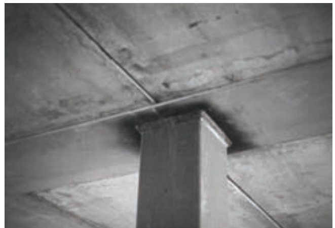
6.9. Verdieping-hoge stalen kolom in het werk gesteld en gelast aan een ligger.
