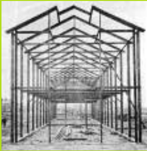
Dorlonco-woningen Landbouwstraat, Amsterdam, 1923 (architect D. Roosenburg).
