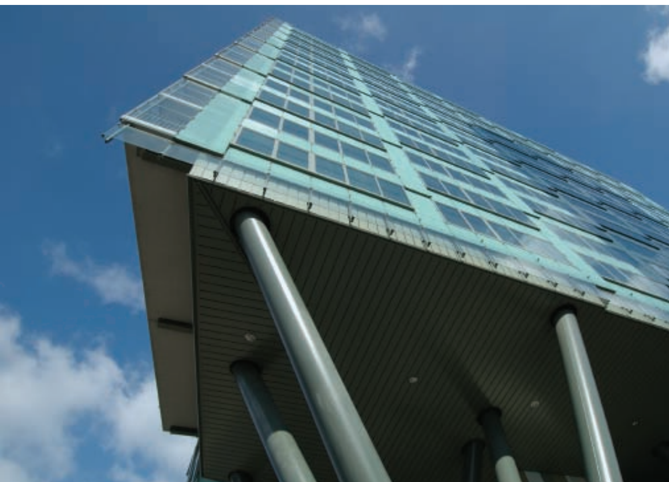
16 De constructie van het tafelblad en de bovenaansluiting van de piramides zijn niet in het zicht gelaten, maar gaan schuil achter een plafond van aluminium planken.
