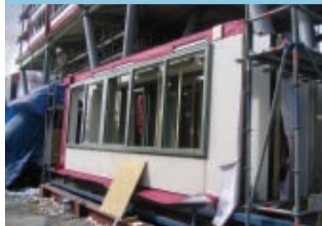
33 In de prefab houtskeletbouw elementen zijn de grote aluminium glasramen al fabrieksmatig aangebracht.
