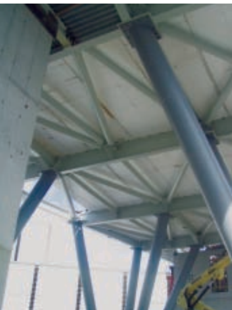
14 Aan de bovenzijde sluiten de piramidebuizen aan via een kopplaat en bouten op de tafelblad constructie.
