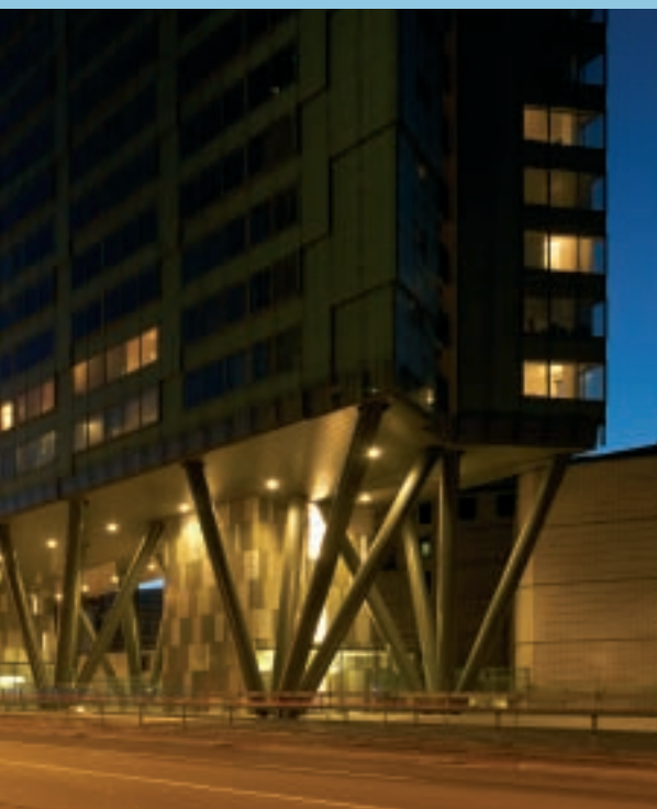
11 Ook bij avondlicht bieden de staalkolommen overzicht op het verhoogde maaiveld.
