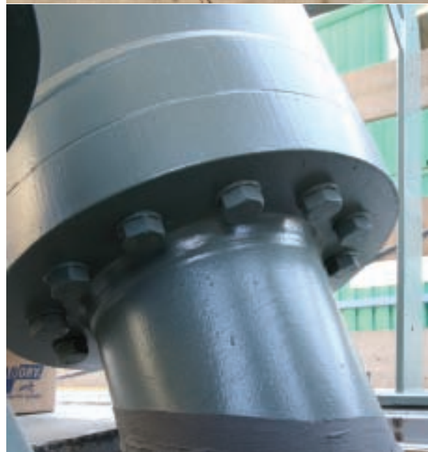
13 De buisprofielen zijn aan de onderzijde verjongd.
