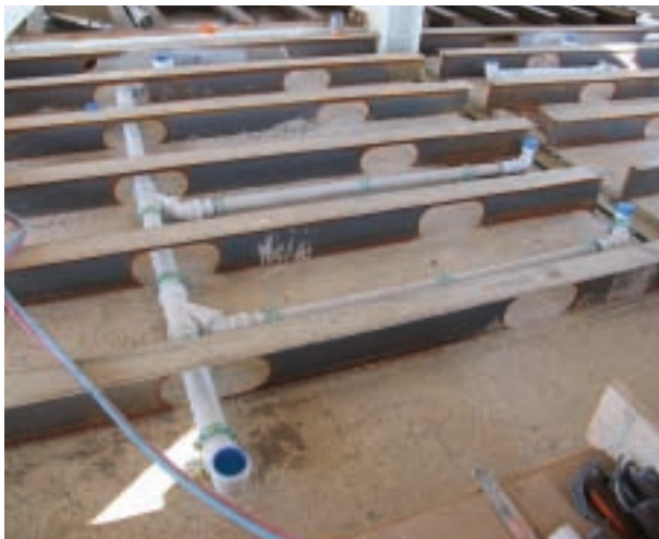
6 Het staalskelet met holle systeemvloeren, waarin de installatieleidingen kunnen worden opgenomen, maakt een vrije indeling van de verdiepingen mogelijk.
