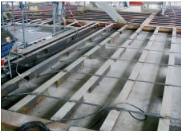
29 Hoewel normaal gesproken geen kipsteunen nodig zijn bij dit type vloer, zijn hier toch plaatselijk stalen banden aangebracht om het uitknikken van de bovenflens te voorkomen vanwege de optredende normaalkracht door de schijfwerking van de vloer.
