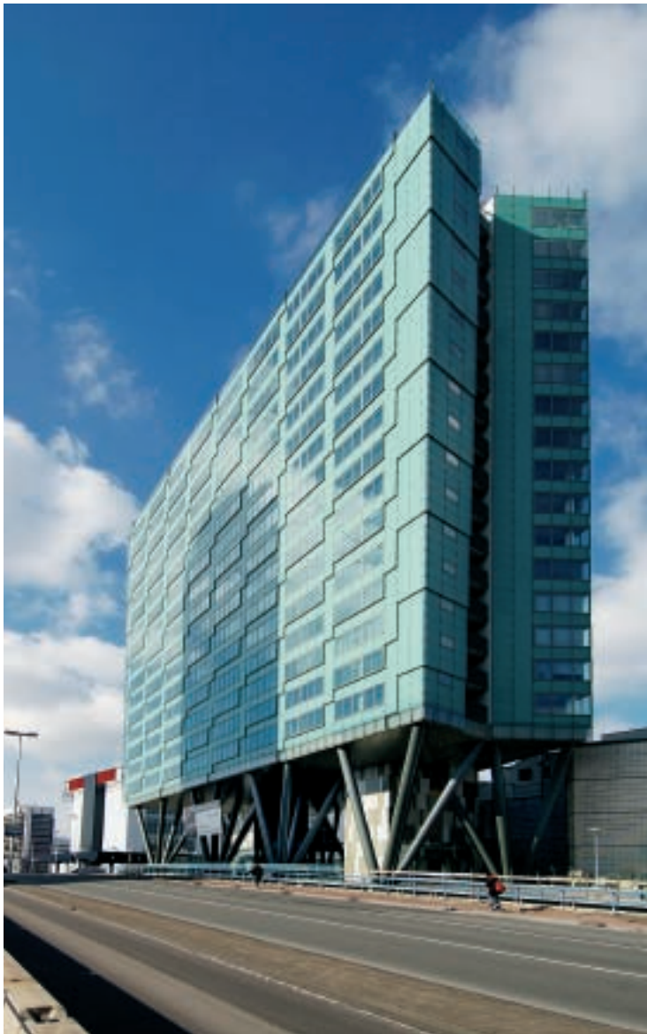
30 Ruimtelijk 'getande' diagonalen geven de glazen gevel een plastische dynamiek.
