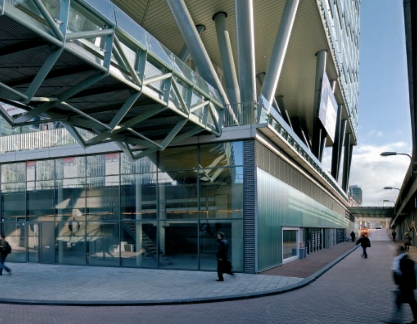
31 De stalen loopbrug verbindt het verhoogde maaiveld met het busplatform.
