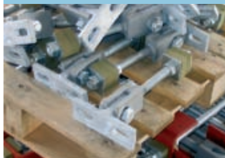
34 Speciaal voor dit project ontwikkelde ankers verankeren het gevelelement in horizontale richting aan de IPE-liggers van de Infra+ vloer.
