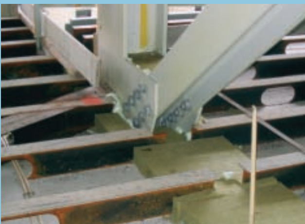
20 Ter plaatse van de woningscheidingen is extra isolatie aangebracht in de vorm van minerale wol.
