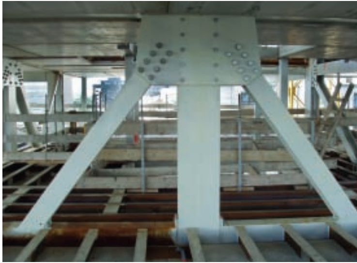
10 De staalskeletconstructie van de bovenbouw bestaat uit kolommen, liggers en verticale windbokken (K-verboden), waarop eveneens Infra+ vloeren zijn aangebracht.
