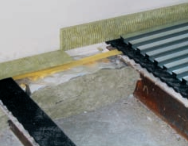
22 Ter plaatse van de oplegging op de staalprofielen is onder de platen 15 mm dik rubbergranulaat toegepast voor de geluiddemping.
