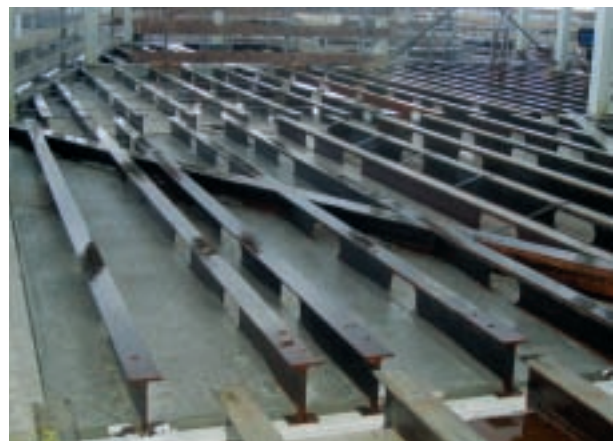
26 Plaatselijk bleken de schoorkrachten in de vloerplaten te hoog, waardoor er ook HE-profielen in diagonale richting zijn toegevoegd.
