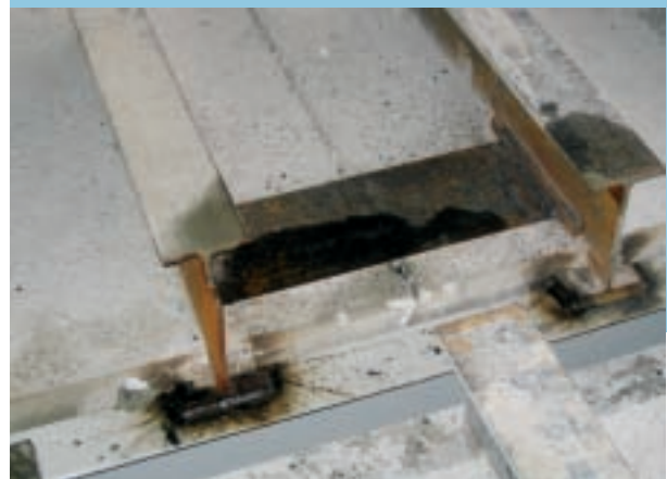
25 Per Infra+ vloerelement van 2400 mm breed zijn er twee van de vier IPE-liggers vastgelast aan de UNP-dragers.
