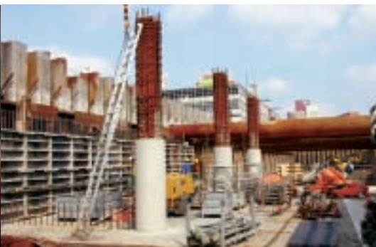
27. De kern van de staal-beton kolommen in de kelder bestaat uit een HD-profiel met aangelaste deuvels.
