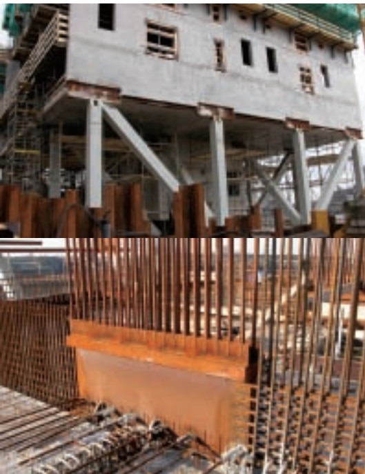
25. Zware stalen I-profielen verzorgen de krachtsoverdracht tussen de beton- en de staalconstructie. Op de I-profielen zijn kammen in de vorm van staalplaten aangebracht, waar het wapeningsstaal tussen is gelast om een goede verbinding te verkrijgen.
