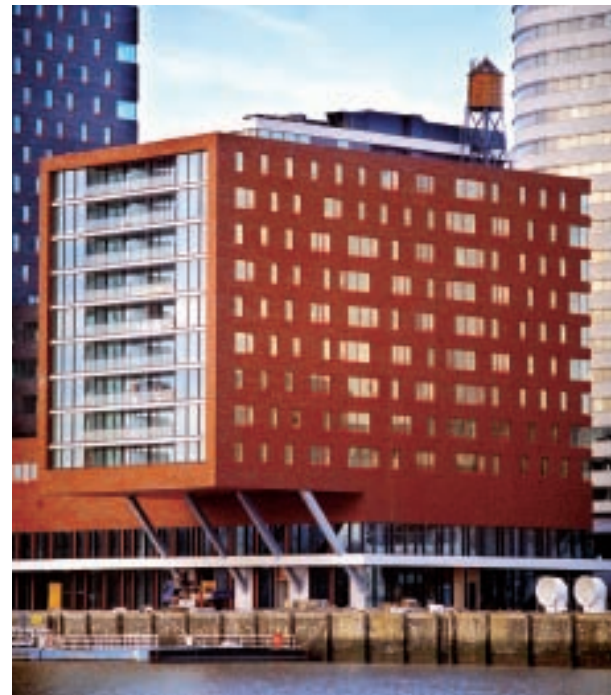
22. De 'cantilever' van links naar rechts: schets van constructeur Walter Spangenberg (zie ook afb. 7 voor de details); bij oplevering; tijdens de montage van de staalconstructie.
