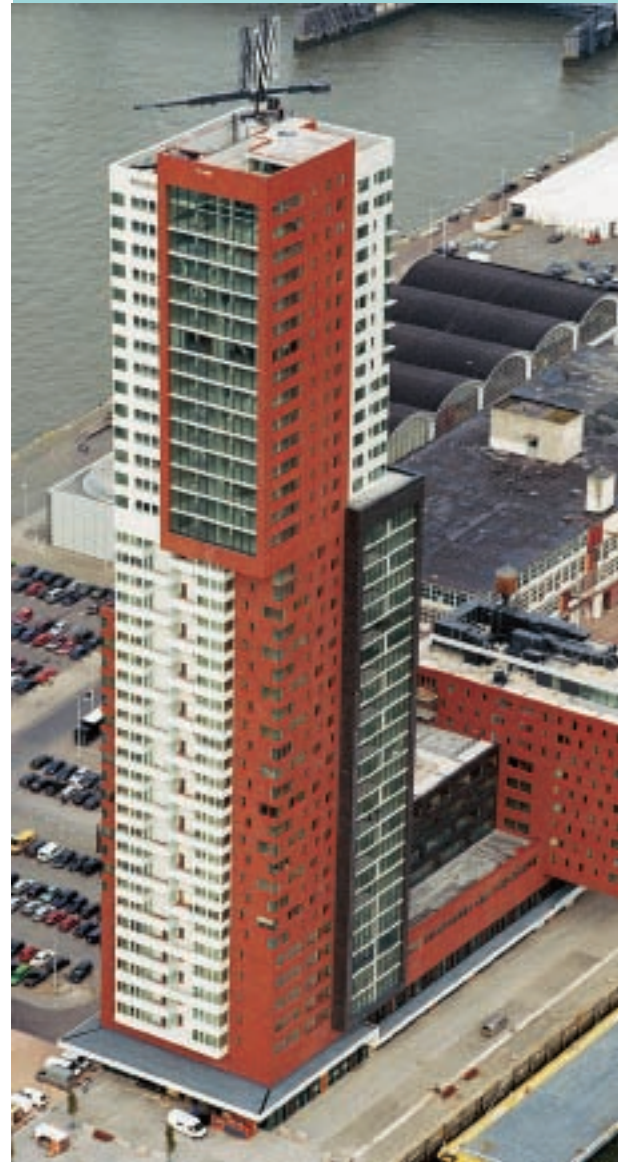
17. Voor het gebouw is een complete veiligheidsstudie gemaakt, waarbij onder meer een mogelijke impact van een vrachtwagen, een schip en een vliegtuig zijn beoordeeld.
