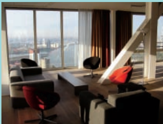
12. In het vrij-indeelbare interieur is de staalconstructie zichtbaar gelaten. De brandwerendheidseis voor de hoofddraagconstructie bedroeg 90 minuten doordat er een sprinkler aanwezig is. De stalen kolommen zijn beschermd met een brandwerende coating.
