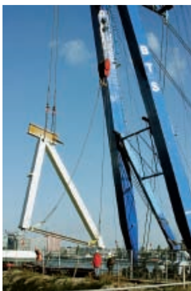
18. Een stalen spant wordt met een drijvende bok ingehesen.
