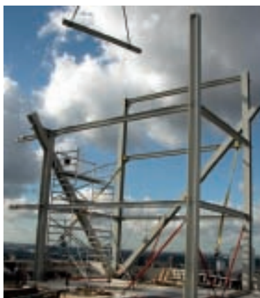
15. Montage van een segment van de stalen gevelbuisconstructie.
