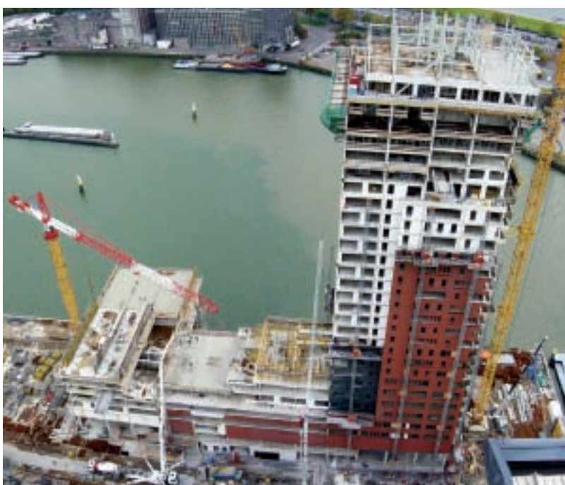
20. De stalen gevelbuisconstructie – zonder betonnen kern – staat boven op de betonnen onderbouw.
