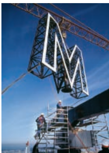
19. Met het plaatsen van de 'M' bereikte het gebouw zijn hoogste punt op 152,317 m boven het maaiveld.
