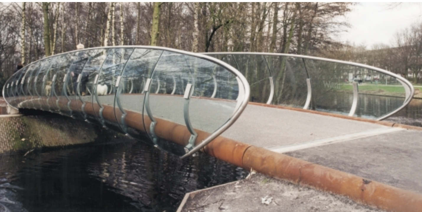
Brug Rembrandtpark Amsterdam van Haskoning.
