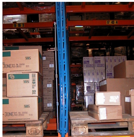
7b. Voorbeeld aanrijdschade (2).
