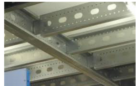
26. Gatenspatroon voor raatliggergedrag met excentriciteiten en gevolgen voor torsiestijfheid.
