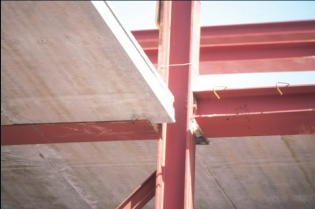
Geïntegreerde stalen liggers met kanaalplaatvloeren en staalplaat-betonvloeren.
