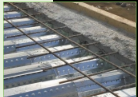
▲ De hoogte van de geprofileerde staalplaat is 60 mm; de dikte van de vloer loopt bij dit project tot 300 mm.
