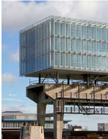
Het Kraanspoor in Amsterdam kreeg Slimline vloeren voor een beperkte verdiepingshoogte.
