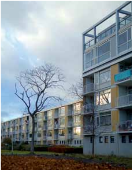
Lichte staalframebouw vloer maakt extra lagen mogelijk.
