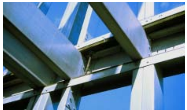
afb. 5.28 Uitvoering stabiliteitsverband en aansluiting strip.
