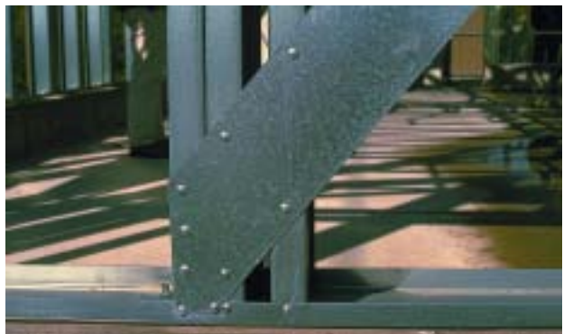
afb. 5.29 Stabiliteitsverband van brede strip.
