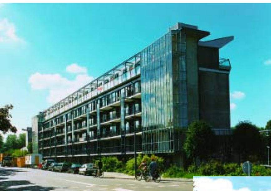
afb. 1.8 Optoppen van flatgebouw in de Componistenbuurt in Maassluis.
