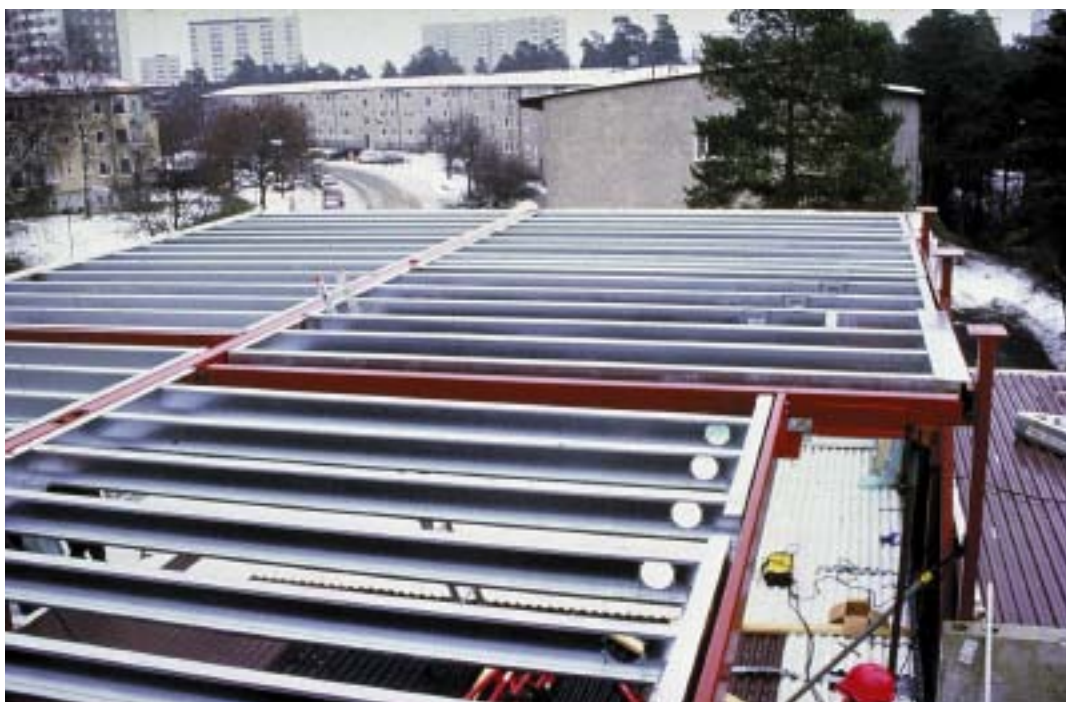
afb. 6.4 Staalframe vloerelement gecombineerd met een geïntegreerde ligger.
