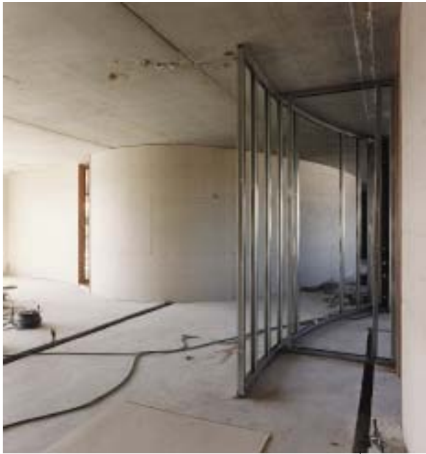
afb. 5.17 Met koudgewalste profielen zijn ook gekromde wanden te maken, zoals met het binnenwandsysteem Vertebra van Gyproc.
