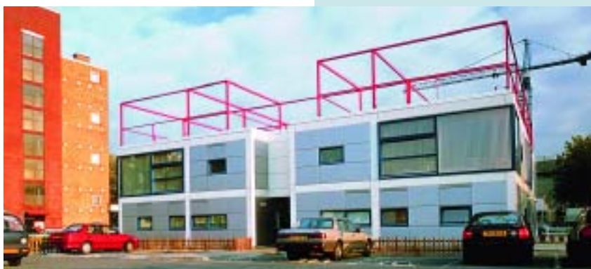
afb. 1.7 Staalframebouw aan de Dedemsvaartweg in Den Haag.
