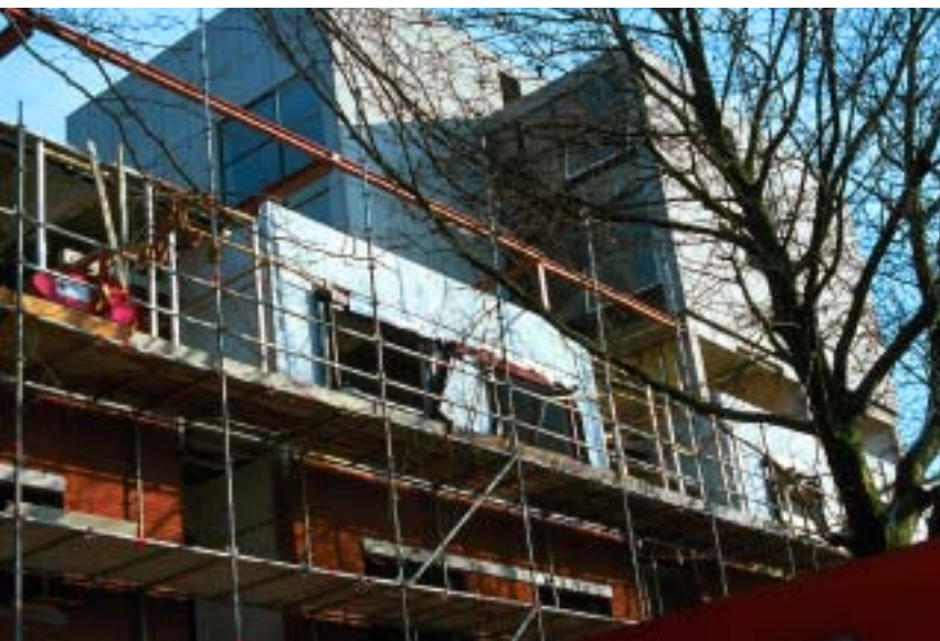
afb. 1.3 & 1.4 Optoppen met staalskeletbouw: studentenhuysvesting in de wijk Blijdorp in Rotterdam.
