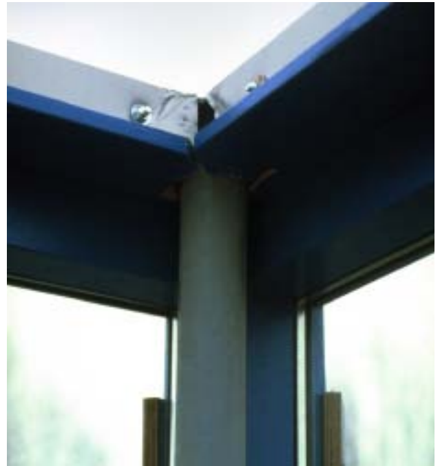
afb. 5.24 Transparante hoekoplossing in staalframebouw aan de Dedemsvaartweg in Den Haag.
