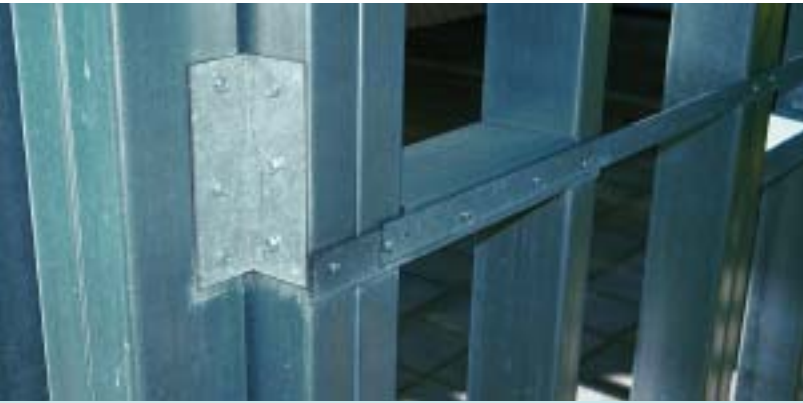
afb. 5.21 Horizontale verbinding tussen op druk belaste C-profielen.
