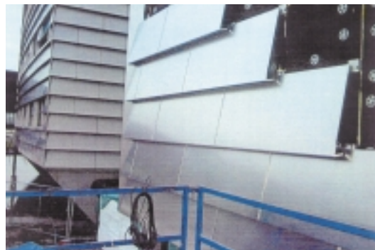
figuur 3 monteren profielen op beugels
