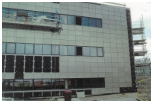
figuur 5 ophangen gevelplaten
