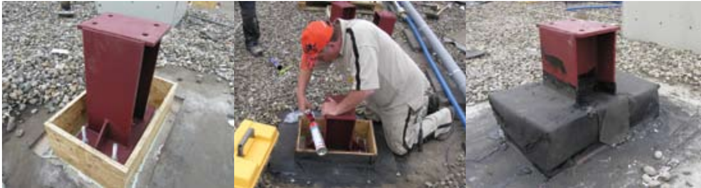
De poten van staalprofielen ( HE 160A en HE 200A ) zijn op een voetplaat gemonteerd en waterdicht afgeplakt.
