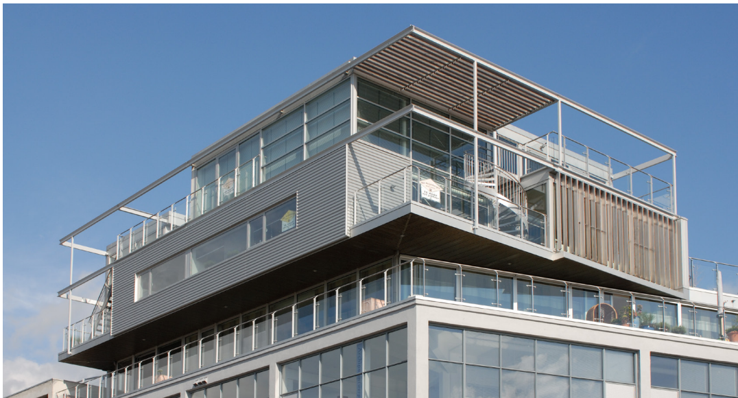
4.32a Ontwerpmaatregel: zoninstraling beperken met een buitenzonwering.
