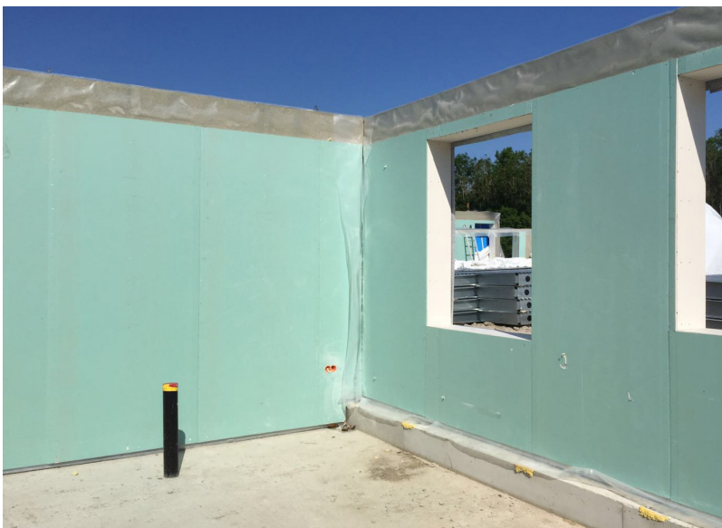
4.18. Folies moeten groter zijn dan de elementen om overlappings te maken bij de naden tussen de bouwdelen.
